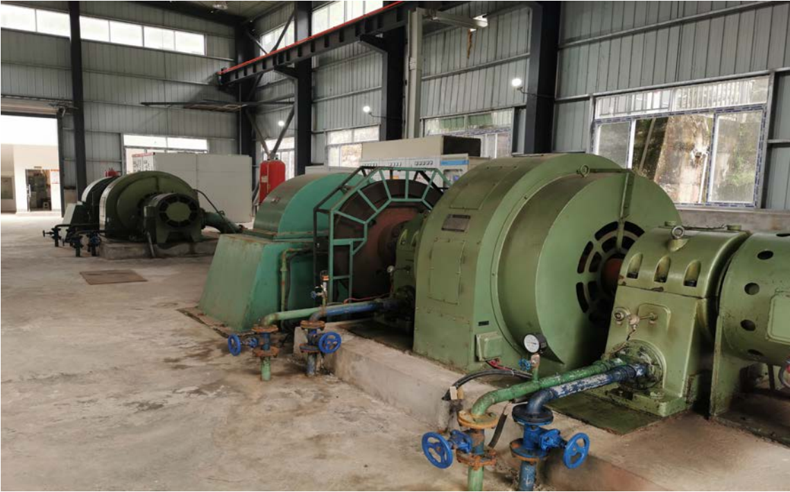
图2.5-5 水轮发电机组
