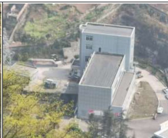
生产厂区现状
