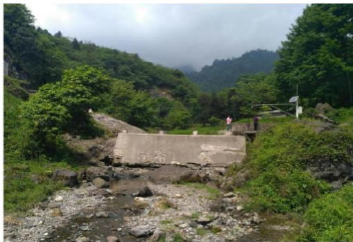
图2-1 取水坝址 2、引水系统
