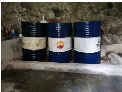
危废暂存间围堰
