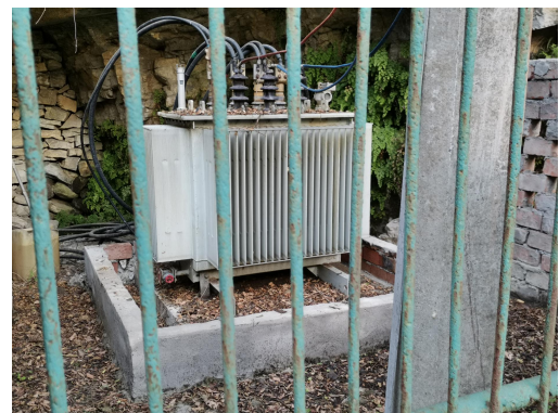
变压器围堰
