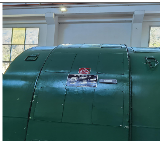
发电机组现状
