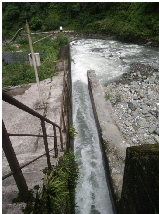
下泄生态流量槽
