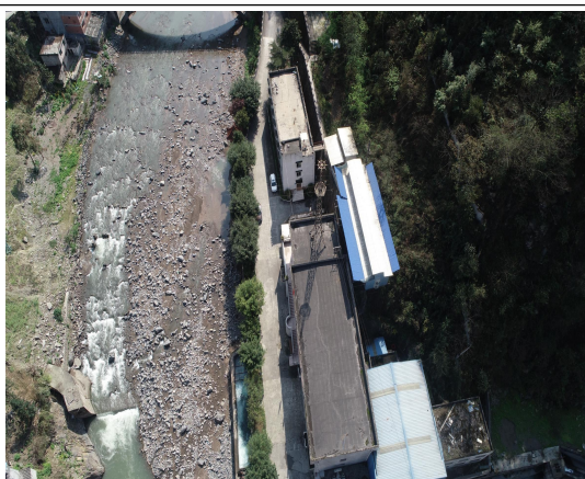
生产厂区现状
