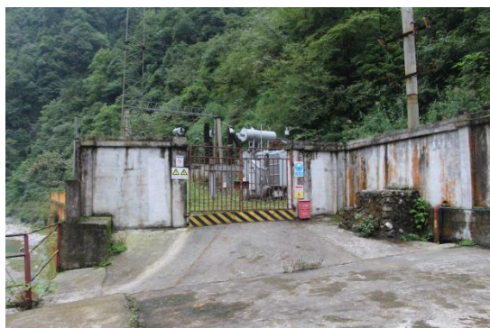
升压站外场地硬化
