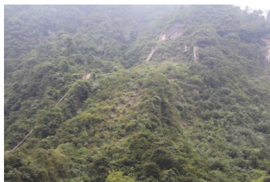
压力管道周边绿化
