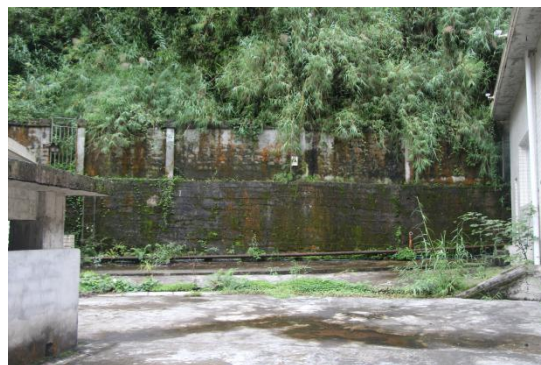
生活区边坡挡墙
