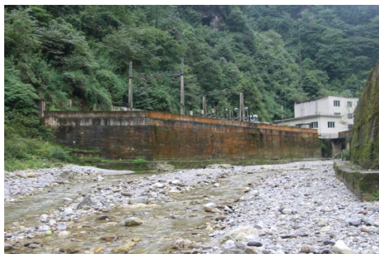
升压站河提（堡坎）
