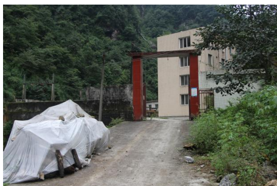
侯山水电站进场道路
