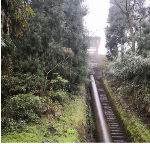
压力管道施工迹地植被恢复
