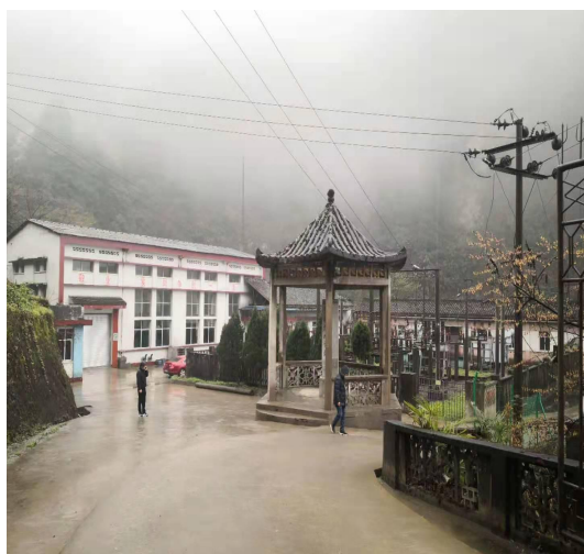
曾板沱电站厂房
