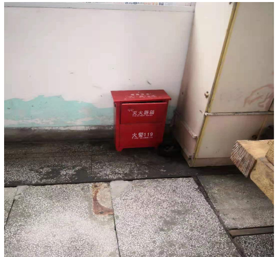
厂区应急设施
