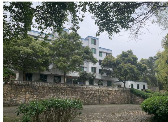
厂房施工工区（位于厂区内）
