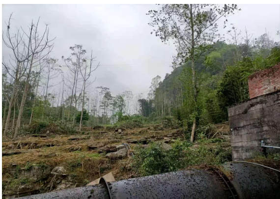
调压井施工工区
