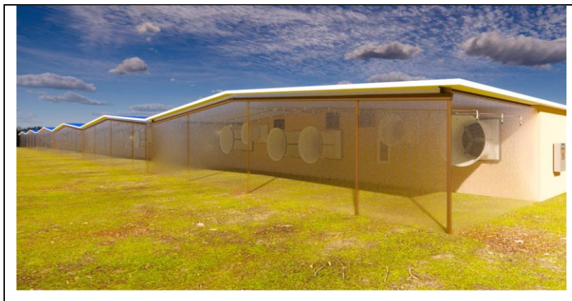
图 8.2-3 圈舍排风口生物喷雾除臭网工程实景示意图
