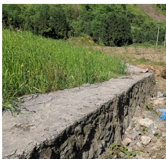
渣场恢复现状
