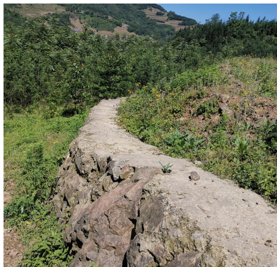
渣场恢复现状
