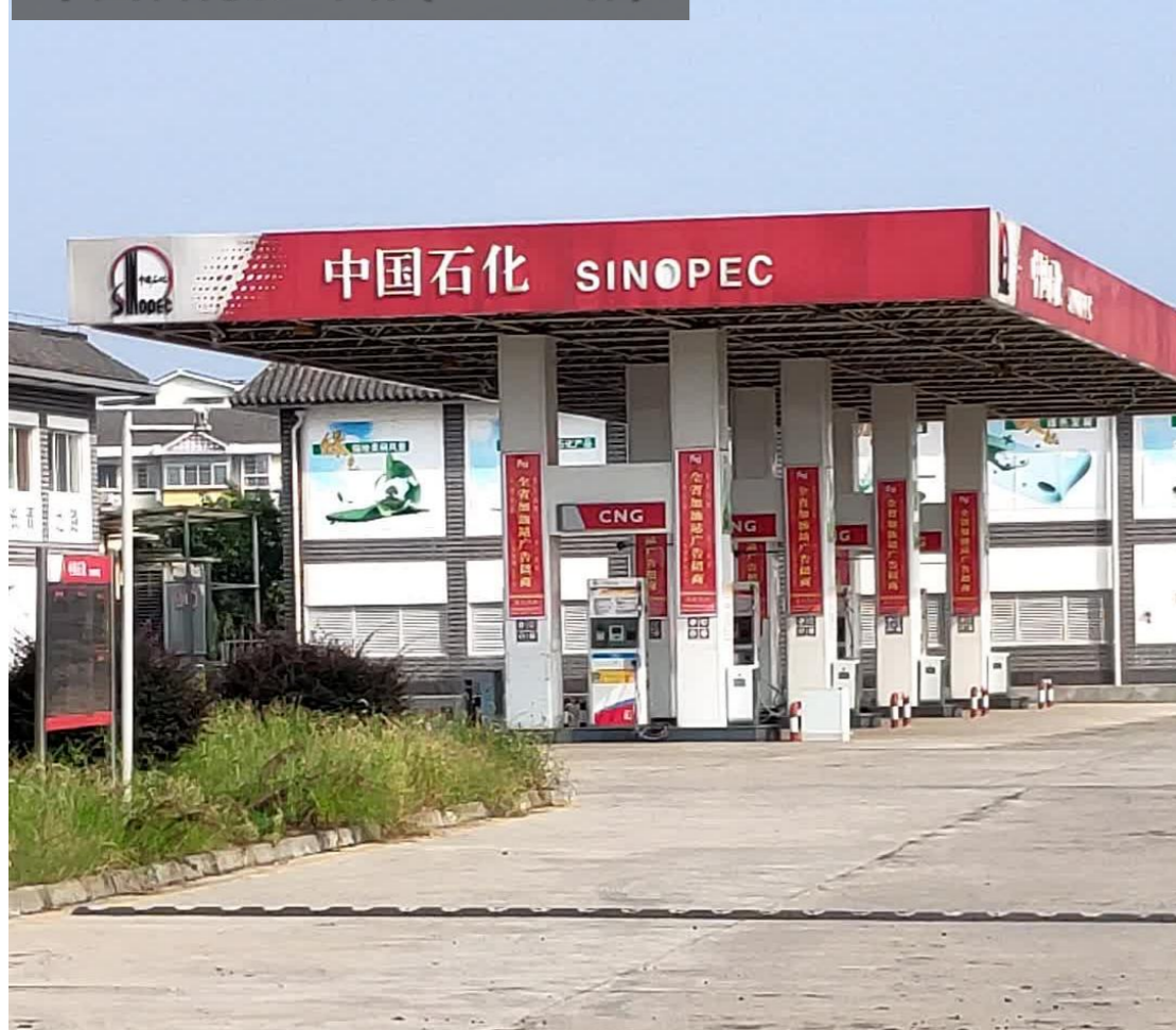
中国石化加气站（CNG站）
