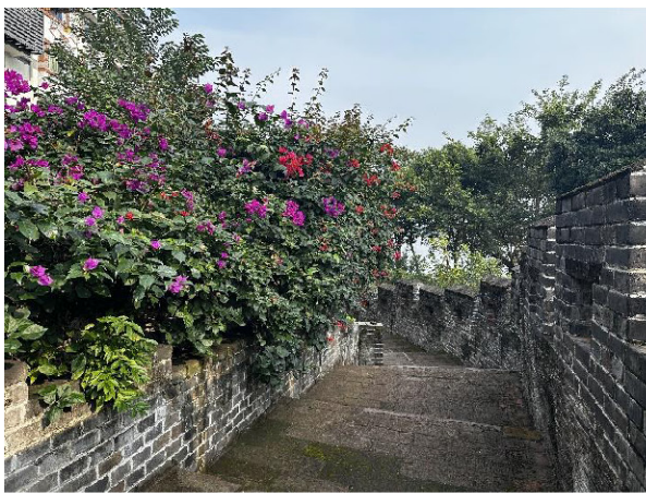
城墙上现状照片
