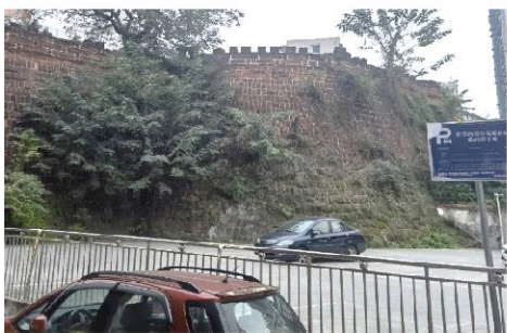
城墙下花园现状
