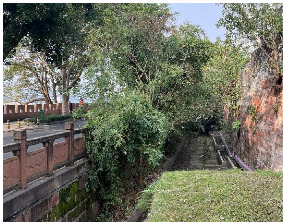
承宣桥外现状照片
